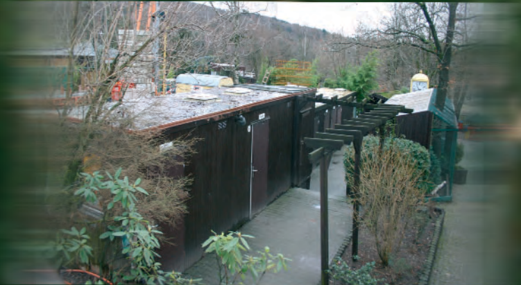
... und die alten Toilettenanlagen...
