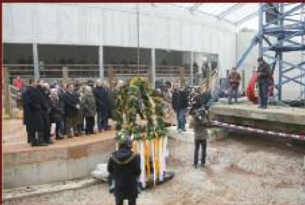
Rohbau Elefantenhaus im November 2012
